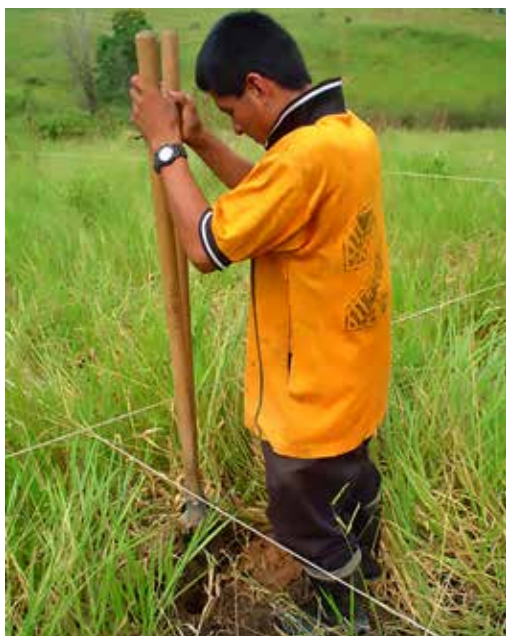
Figura 18. Hoyado manual (Izquierda) y hoyado mecánico (derecha)
