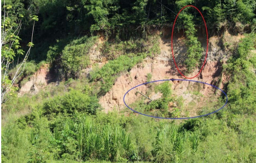
Figura 3: 2C antes de la limpieza y lavado. La avalanche de rocas había cubierto la mayor parte de la parte inferior de esta sección (círculo azul) y la vegetación había crecido hacia la colpa desde abajo. El bambú crecía sobre la parte superior de la colpa (círculo rojo) y comenzaba a cubrir el medio de 2C.
