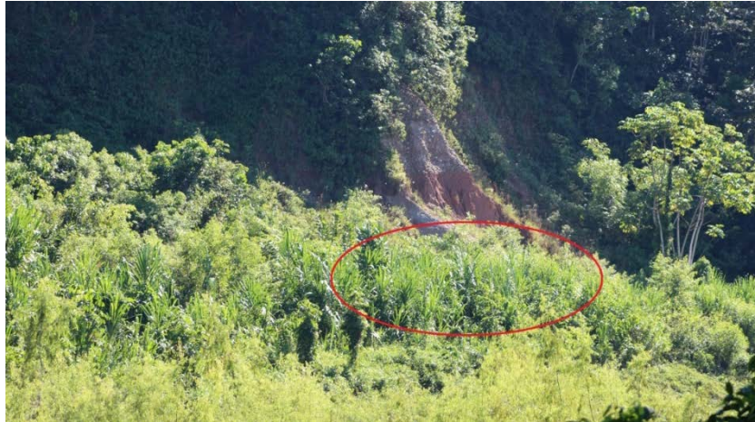
Figura 7: 3C antes de la limpieza. Caña brava y otro tipo de vegetación bloqueaban la vista de la parte inferior de 3C (círculo rojo). Una avalancha de rocas cubrió áreas a lo largo de la parte inferior de esta sección.
