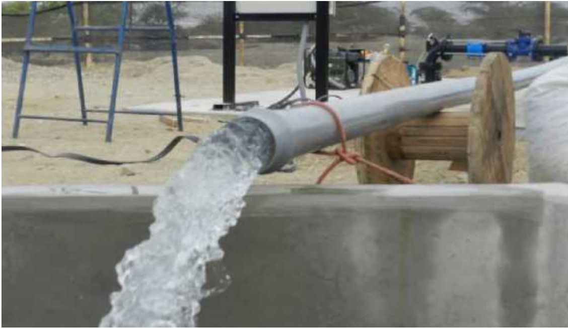
Prueba de Bombeo
